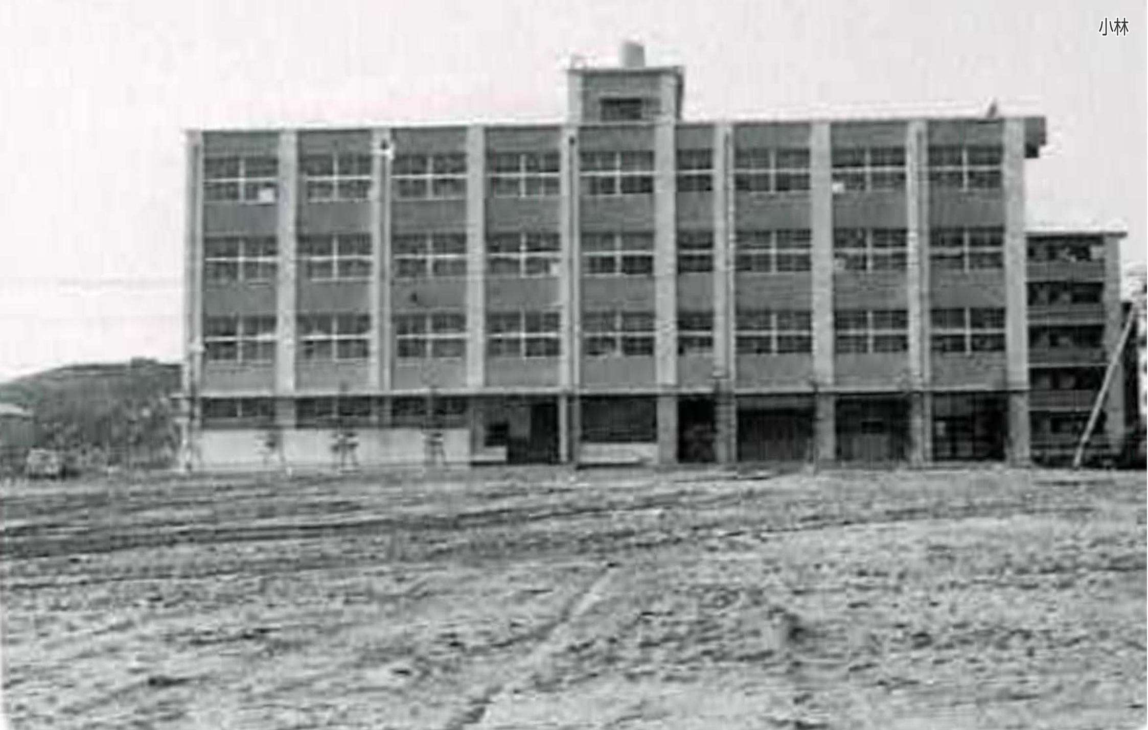
小林小学校（昭和46年頃） 建築中の様子
