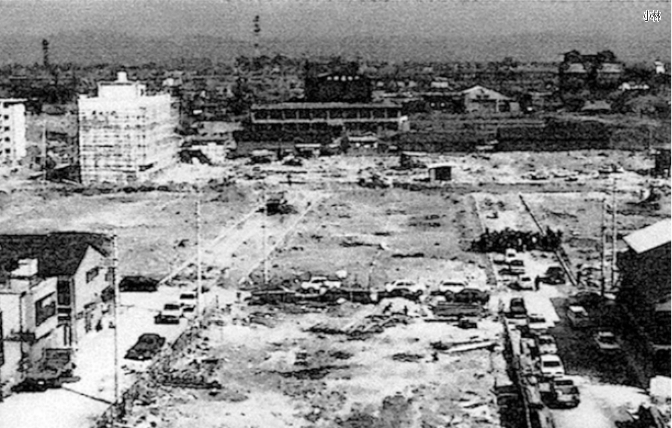
小林小学校（昭和46年） 建築中（左奥が校舎）の様子。
