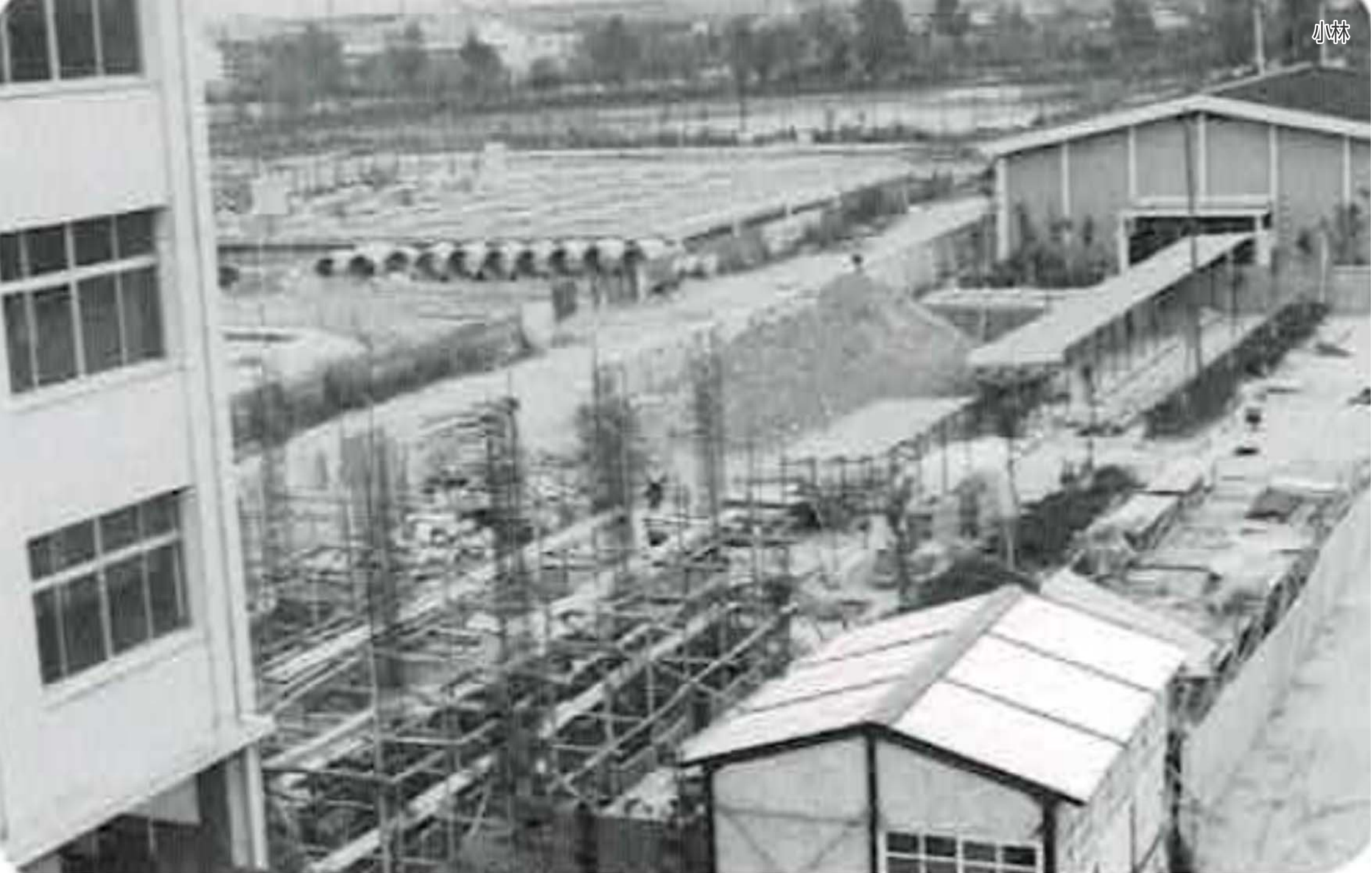
小林小学校（昭和55年頃） 新校舎（東校舎）増築工事
