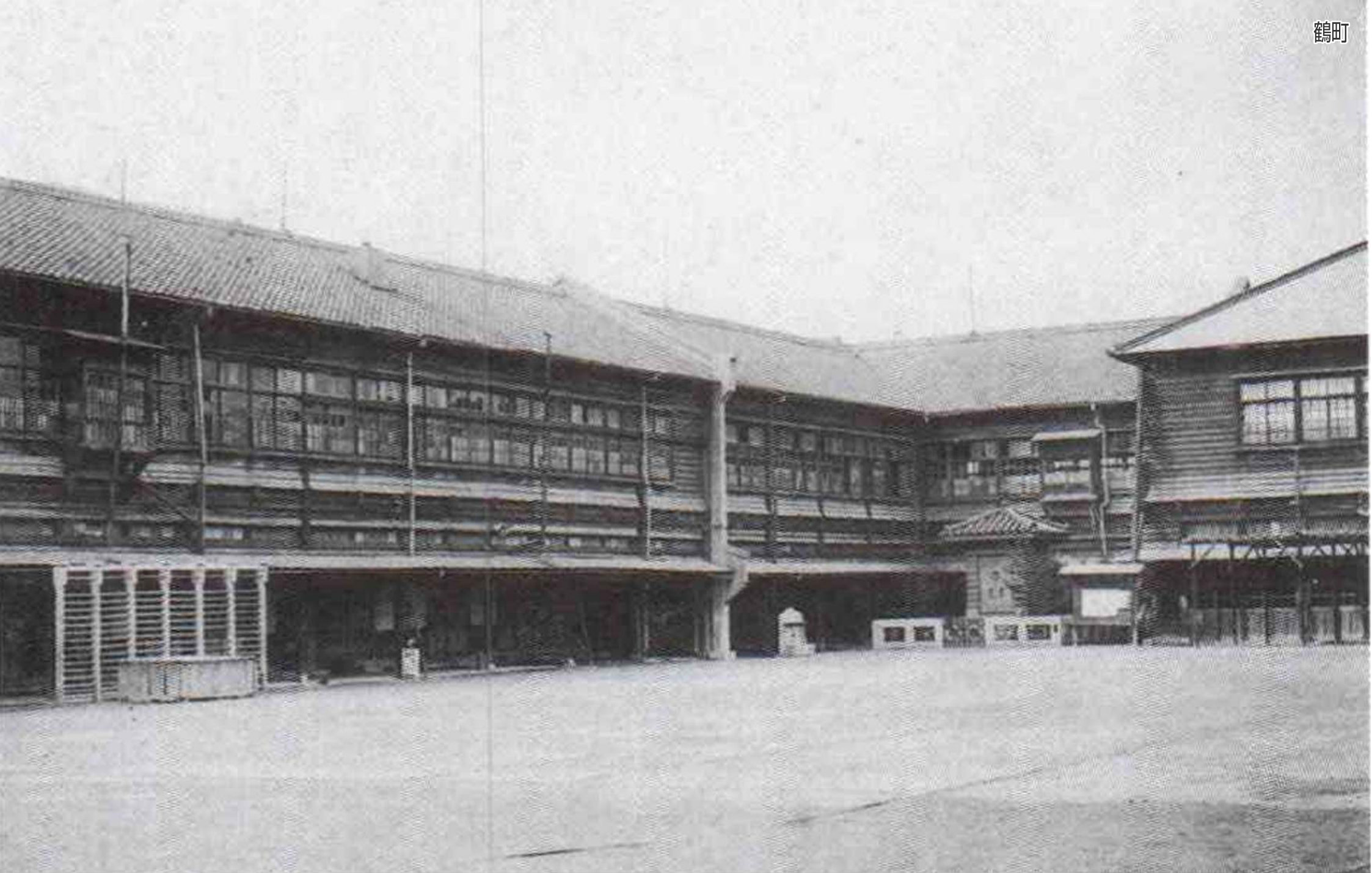
鶴町尋常小学校（戦前） 運動場から見た校舎と奉安殿
