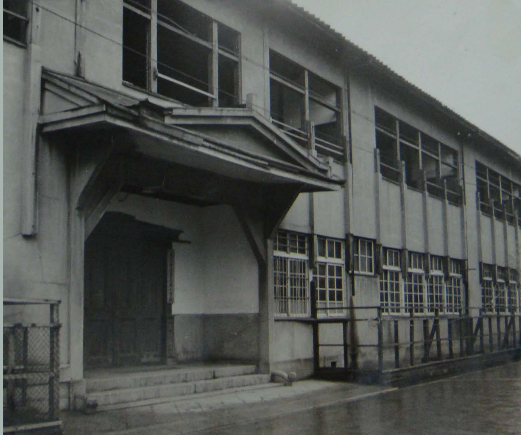
泉尾北小学校（昭和29年頃） 木造2階建て校舎の入口
